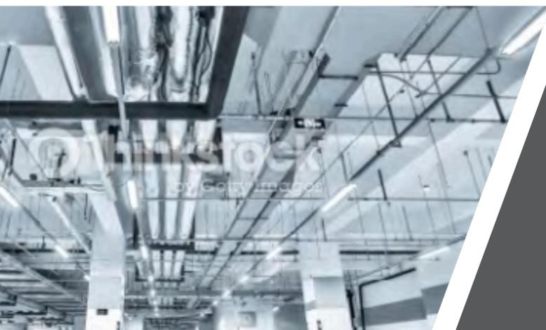
// Kanäle aus Stahlblech, verzinkt, pulverbeschichtet oder in Edelstahlausführung - alles ist möglich
